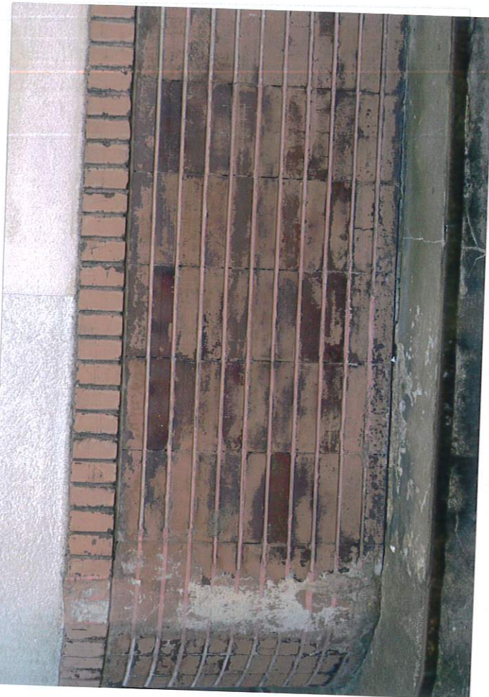
Fot. 8. Okładzina cokołu na elewacji od podwórza.
